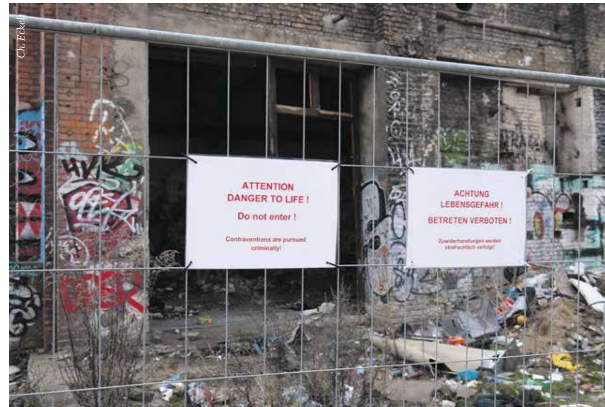
Die Eisfabrik Anfang Januar. Inzwischen werden die Eingänge zugemauert.
